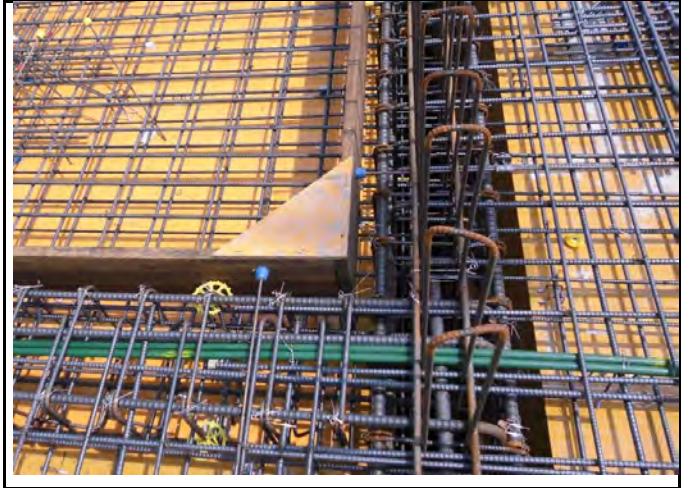
水回り段差施工例
